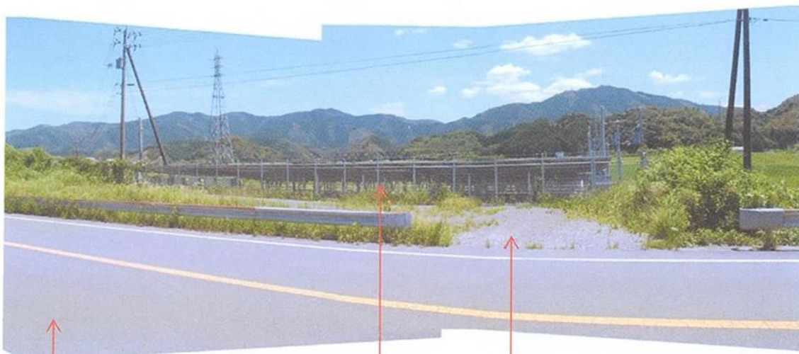
2 国道 フェンス 国道敷地
