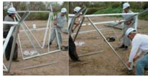
架台の脚を開いて簡単設置
